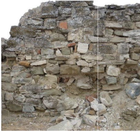
Слика 13: Одделување на камењата по издвојувањето на поситните честички
