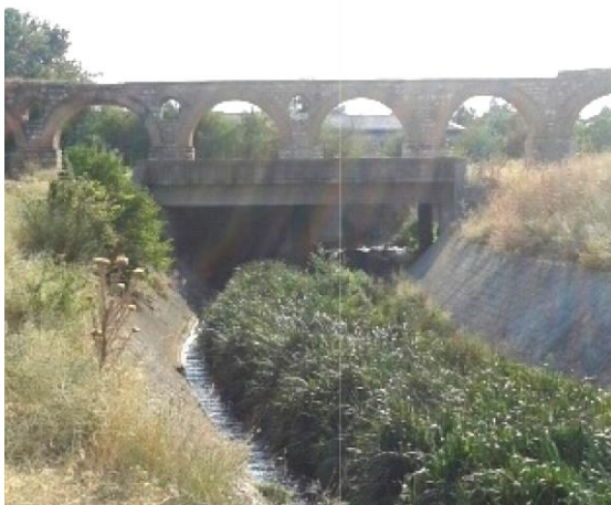
Слика 2: Канализирано корито на Серава под сводовите 31-33 од Аквадуктот
