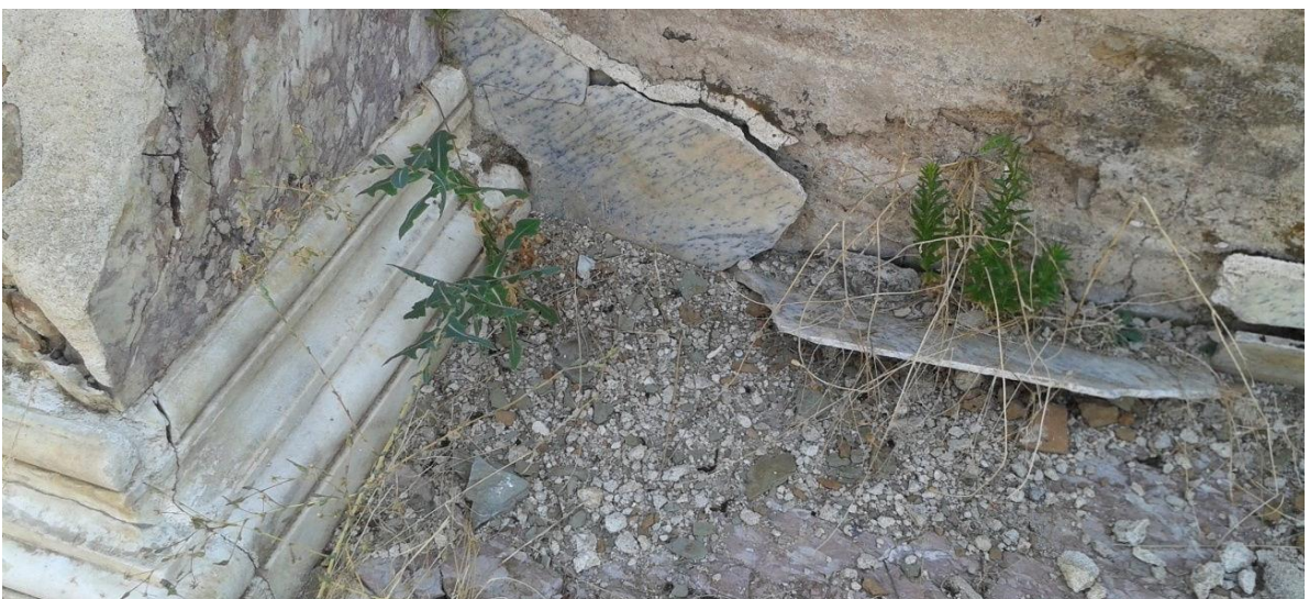
Слика 19: Одделување на површинските слоеви како резултат на мрзнење и вегетација
