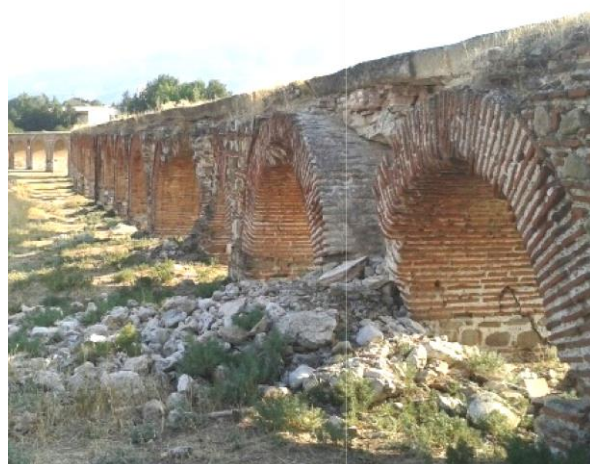
Слика 6: Оштетувања предизвикани од навлегување на дождовница
